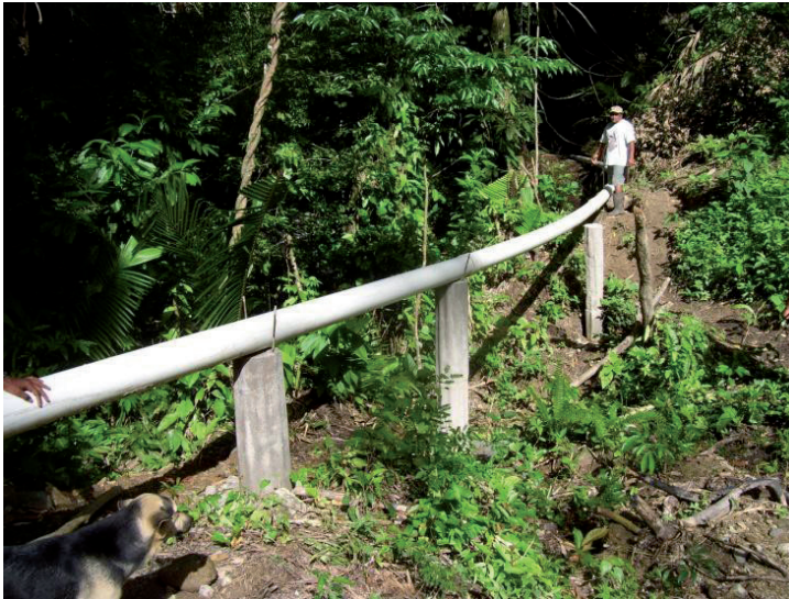
FIGURA 7. Instalación de soportes para salvar la distancia entre la tubería forzada y las irregularidades del terreno
