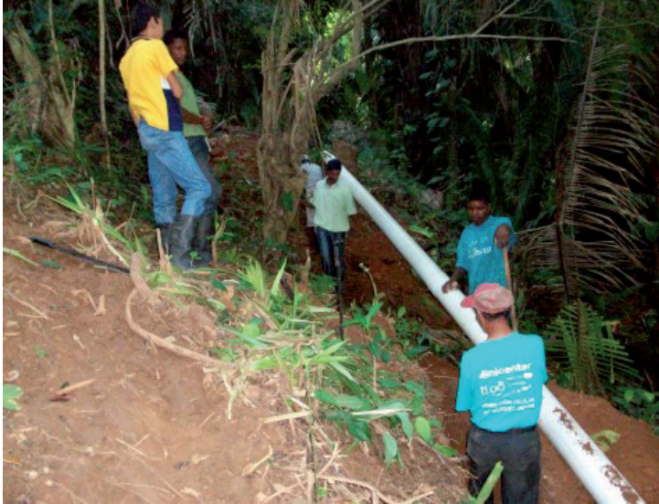
FIGURA 6. Instalación de la tubería forzada
